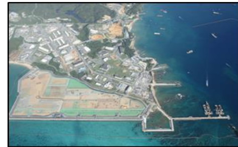
【普天間飛行場代替施設の建設】
