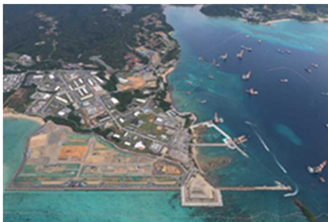
普天間飛行場代替施設の建設
