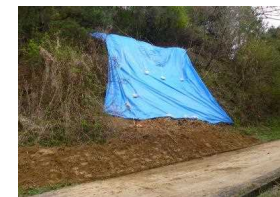
応急対策中の法面(イメージ)
